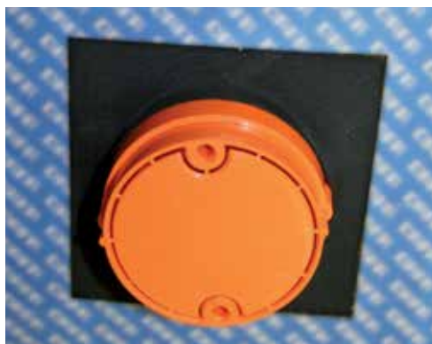
Eksempel på vindtæt installation med universalkrave.
